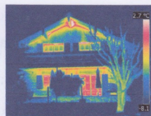
FIGURE 3 – Rayonnement thermique émis à l'extérieur d'une maison.
