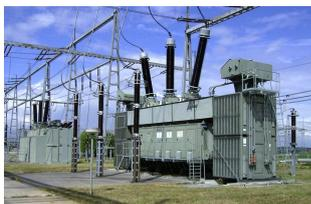
Le transport de l'électricité sur le réseau électrique se fait à très haute tension (ce qui diminue les pertes par effet Joule sur les lignes). Il faut donc installer proche des villes des transformateurs qui abaissent la tension qui sera délivrée aux utilisateurs.
